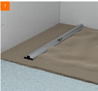
7 ... und auf den leicht verdichteten Dämmen abgezogen
