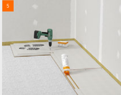
Verlegen der fermacell® Estrich-Elemente auf fermacell™ Ausgleichsschüttung
