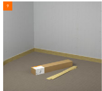
9 Bei Bedarf erfolgt das Anbringen eines Randdämmstreifens
