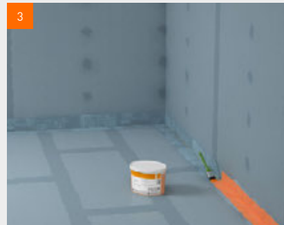
3 fermacell™ Flüssigfolie in der Ecke auftragen
