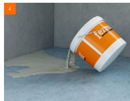
Boden-Nivelliermasse ausbringen und planeben nivellieren
