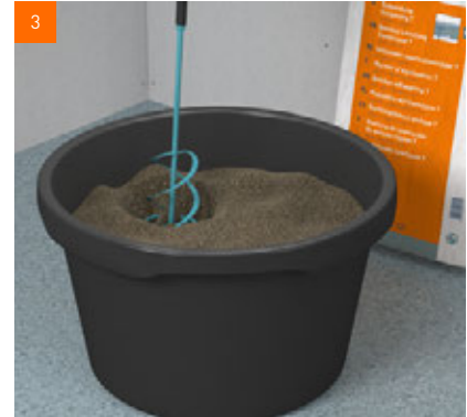
3 ... gründlich zu durchmischen. Bei Schütthöhen unter 20 mm max. 8,5 Liter pro Sack.
