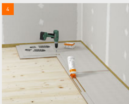
4 Auftragen des fermacell™ Estrich-Klebers im Falzbereich
