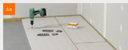
3 Verlegen der fermacell® Estrich-Elemente
