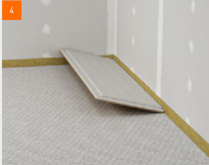
fermacell® Estrich-Elemente verlegen
