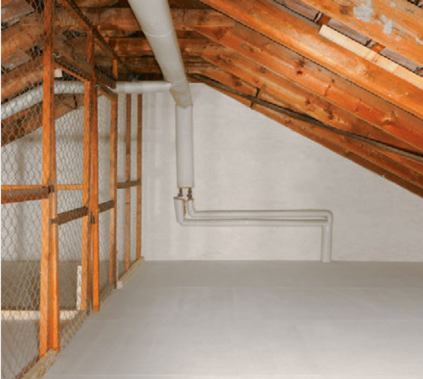
Nut- und Federverbindung: Schnelle Verlegung ohne Wärmebrücken
