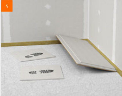
Verlegen der fermacell® Estrich-Elemente auf fermacell™ Ausgleichsschüttung
