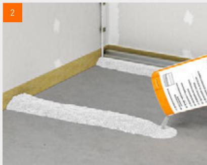
Anlegen der Dämme
