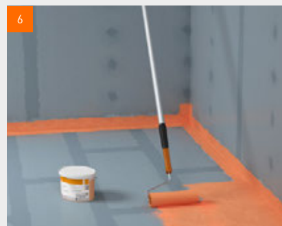
6 Dichtband direkt nach dem Eindrücken mit fermacell™ Flüssigfolie überstreichen - Trocknungszeit mindestens 1 Stunde
