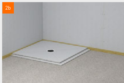
Variante B: Man zieht in Höhe der Oberkante des Ablaufgehäuses die gesamte Fläche mit der gleichen gebundenen Schüttung ab und setzt das Duschelement
