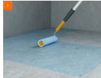
Vorbereitung: Boden grundieren
