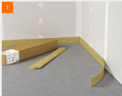
Anbringen der Randdämmstreifen
