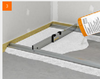
fermacell™ Ausgleichsschüttung einbringen
