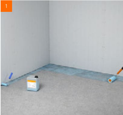
1 Grundierung des Untergrundes mit fermacell™ Tiefengrund
