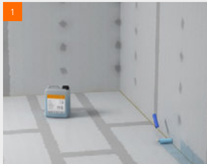
1 fermacell™ Tiefengrund im angrenzenden Wandbereich ...
